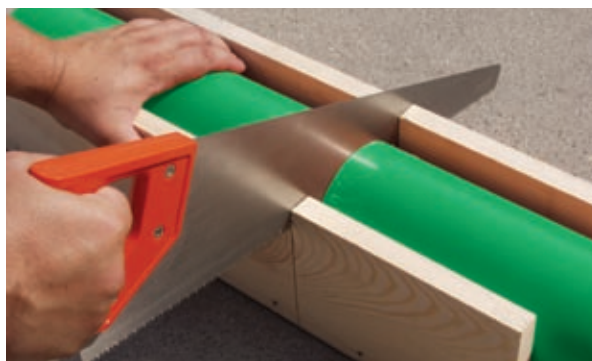
Obrázek 10 Zkracování trubky pilkou
